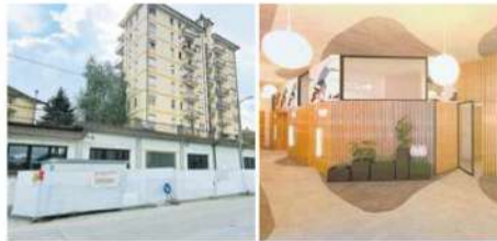
Il cantiere in via Cappellari e un dettaglio degli interni (rendering) della casa funeraria di Caldart
