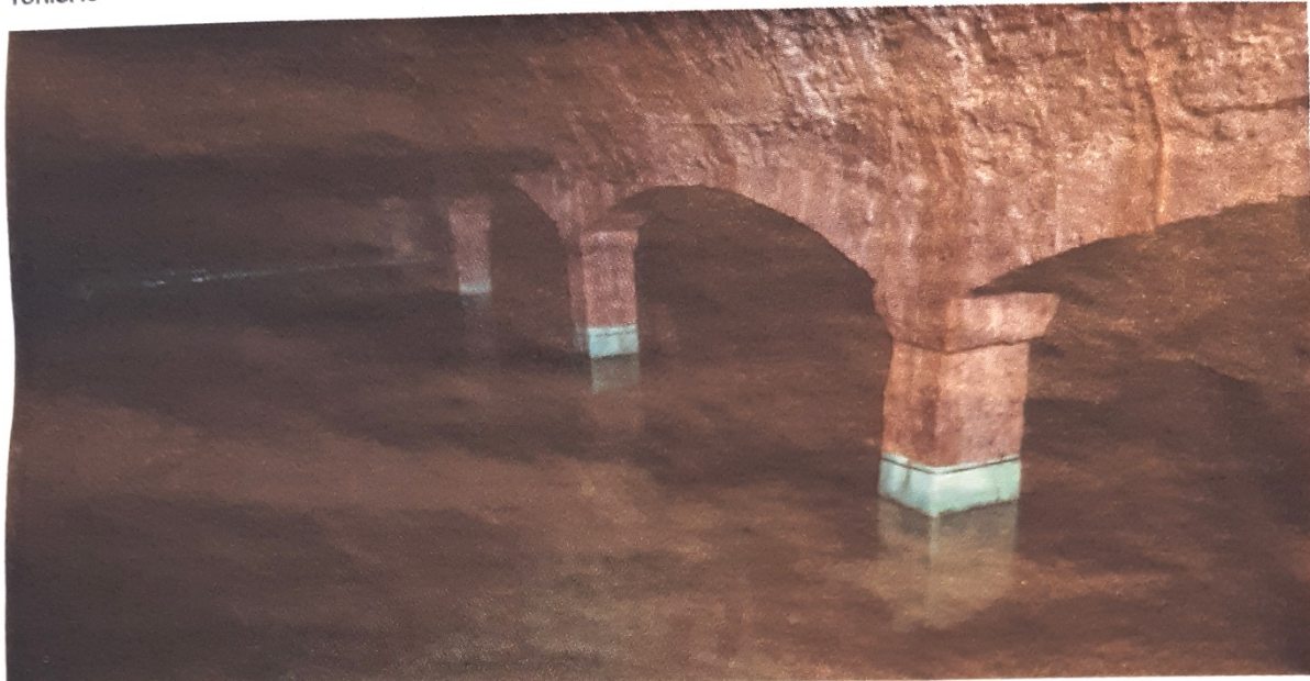
L'interno delle cisterne sotterranee che alimentano le fontane Lombardesche
