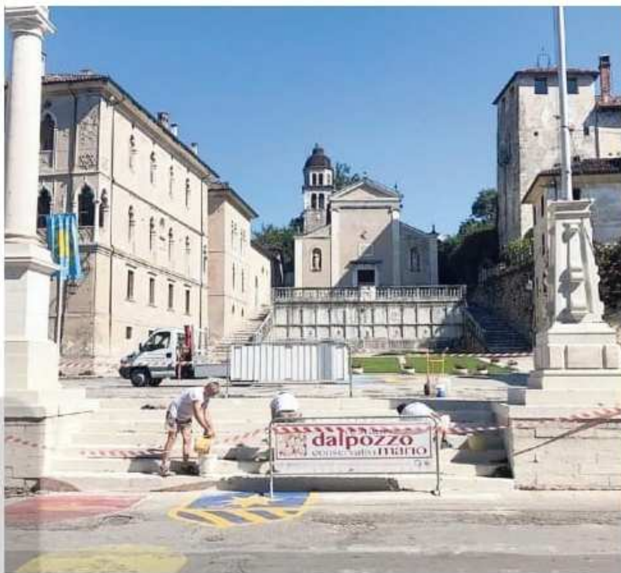
In primo piano la scalinata oggetto di recupero, sullo sfondo le Fontane Lombardesche e San Rocco
