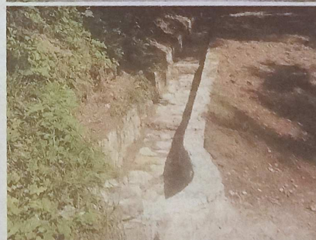
Due immagini dei lavori a Borgo Valbelluna
