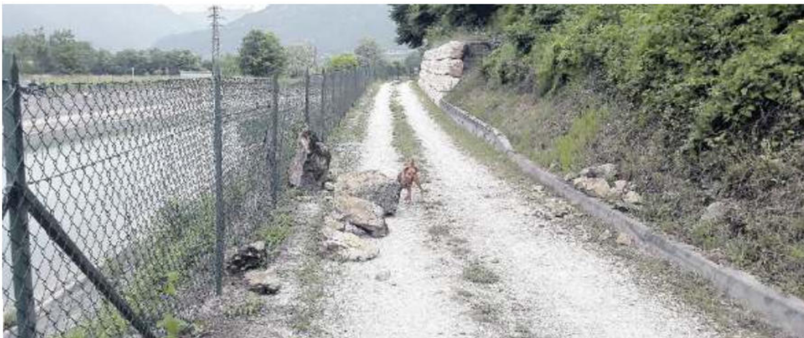
LA MANUTENZIONE Il tratto di ciclabile interessato dall'intervento di messa in sicurezza dalle frane che scendono dal versante del monte
