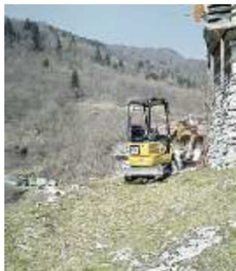
IL CANTIERE Per cercare di rilanciare il Col dei Bof
