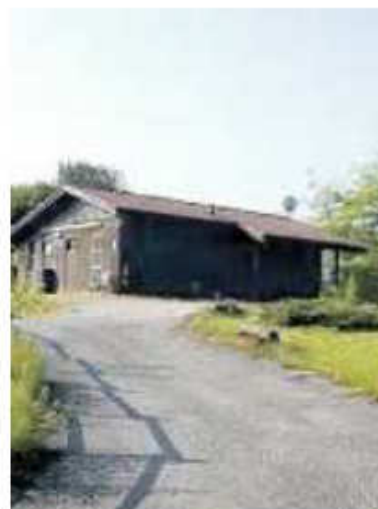
LA VECCHIA Struttura turistica di Longhere ora demolita
