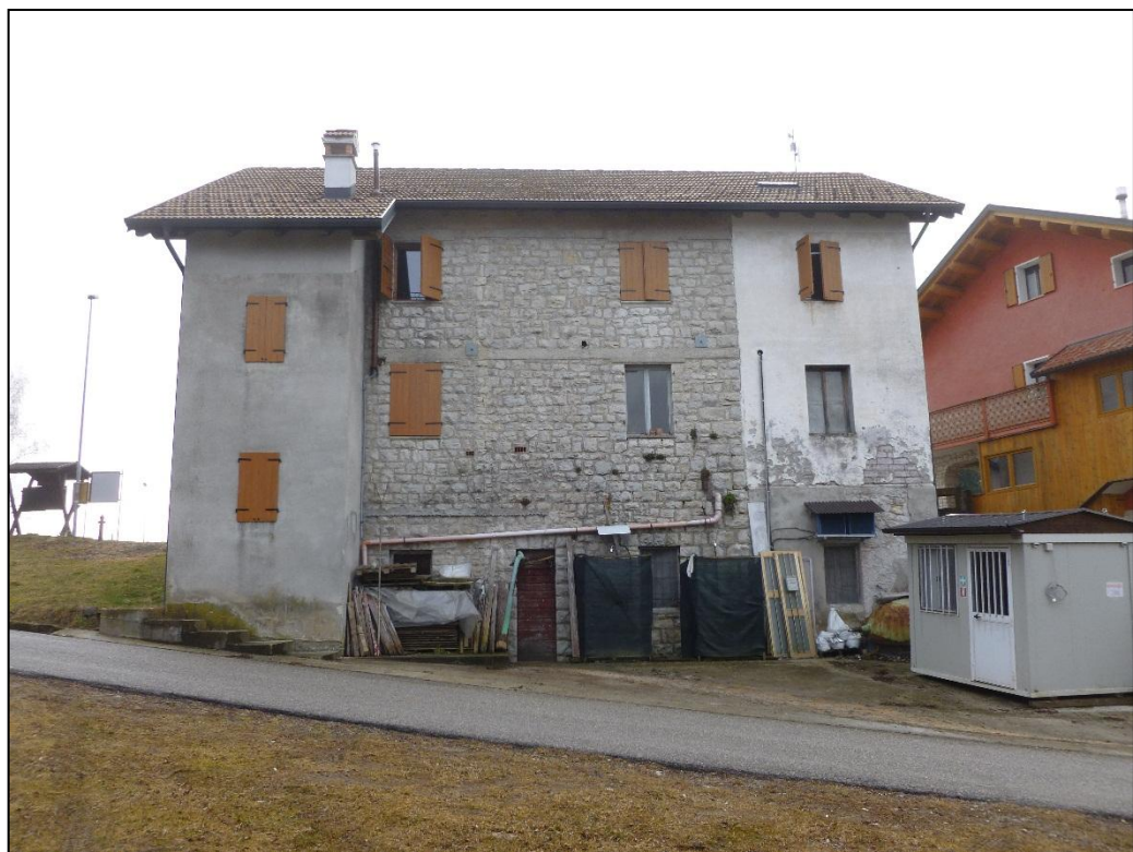
Foto 2: vista del fronte nord-est della “Latteria Val Morel”.
