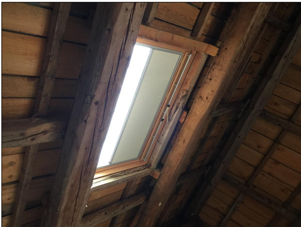
Foto 8: vista in dettaglio del tetto della casera di “Malga Pianezze”.
