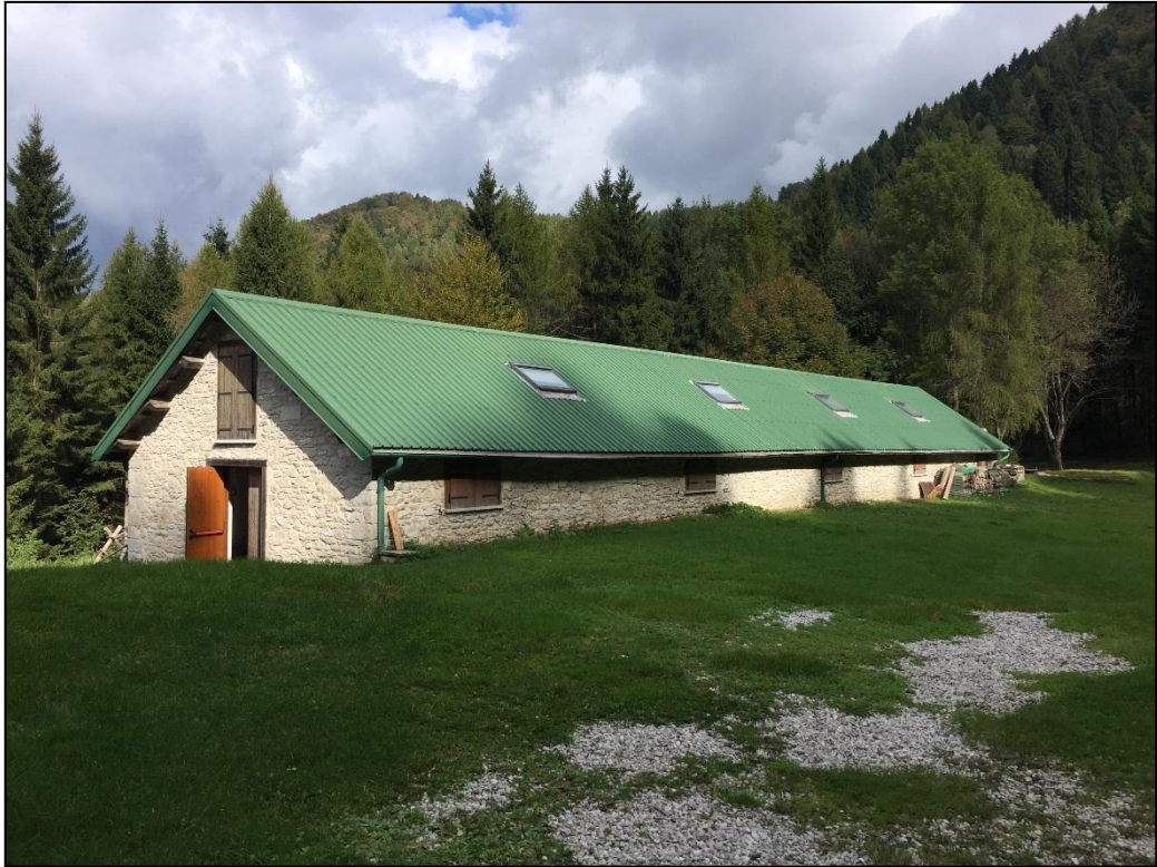
Foto 5: vista dei fronti ovest e sud della casera di “Malga Pianezze”.
