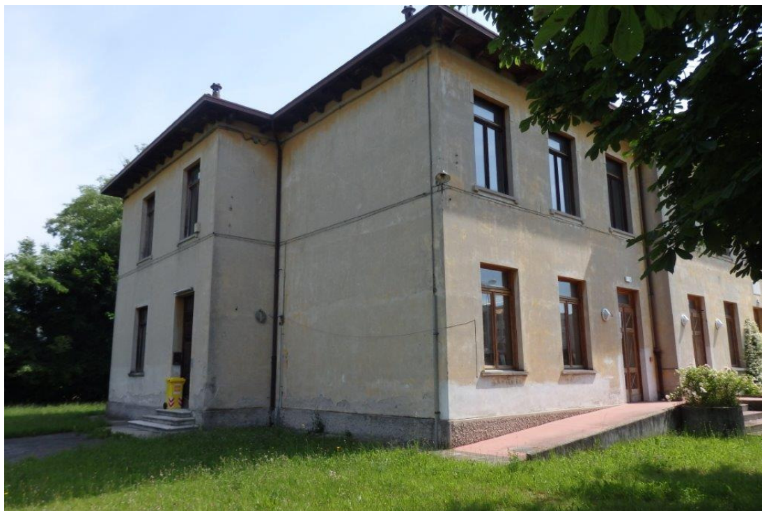
Foto 3: vista angolo sud ovest porzione di edificio interessata dall'intervento
