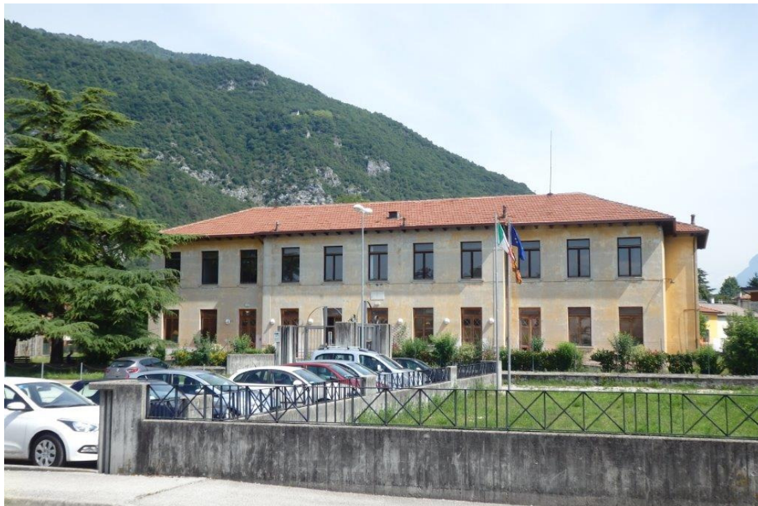
Foto 2: vista attuale del fronte sud
