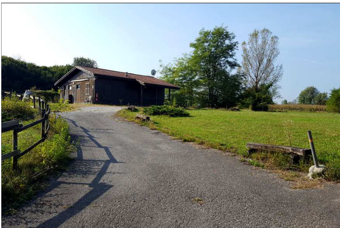
Fig. 8 - Vista dell'accesso al fabbricato.
