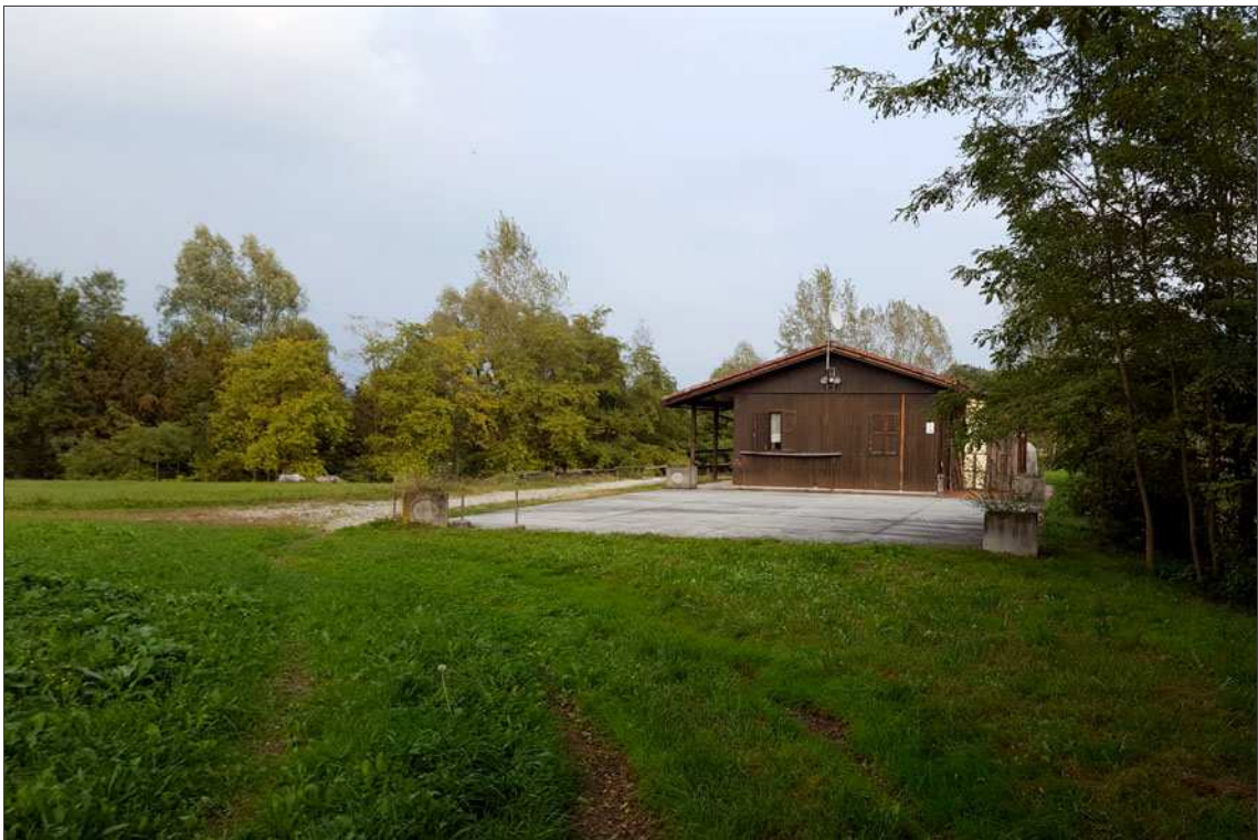
Fig. 10 – Prospetto ovest e soletta in calcestruzzo antistante.
