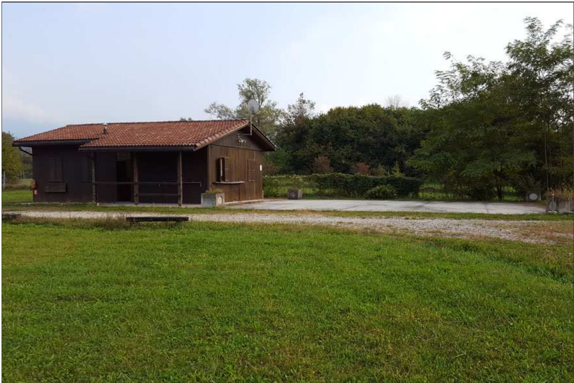
Fig. 9 – Vista dei prospetti nord ed ovest.
