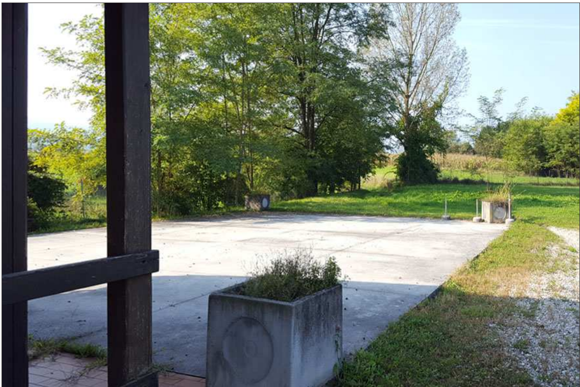
Fig. 14 – Soletta in calcestruzzo posta lungo il lato ovest.
