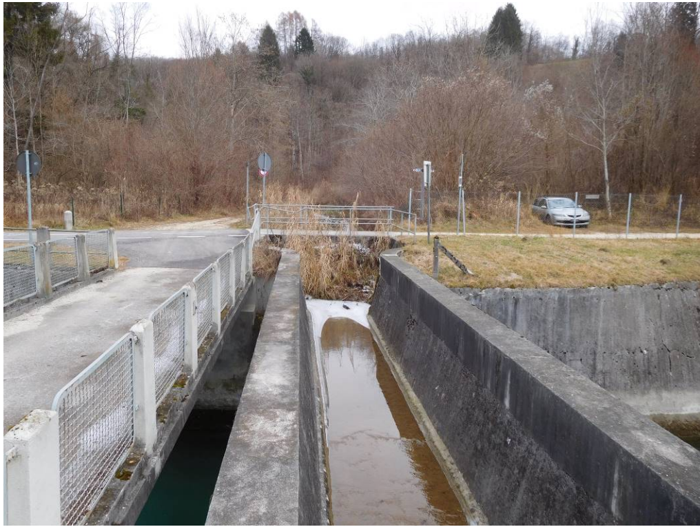
Foto 4, 5: vista di tombotti di scarico della idrografia secondaria che si immette in alcuni tratti sul canale principale, il Cellina.
