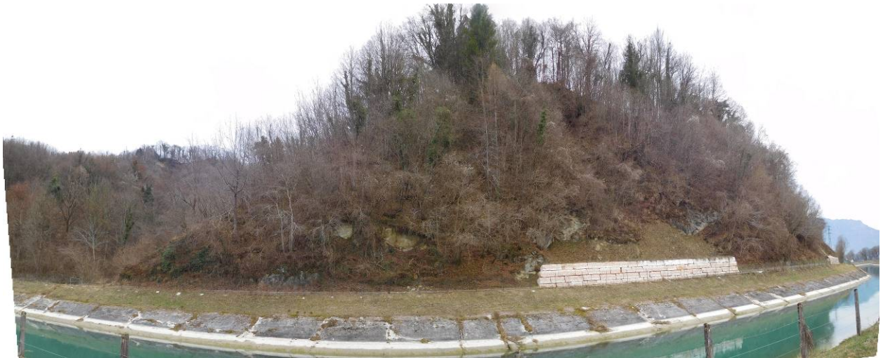
Figura 1: Vista del tratto iniziale oggetto di intervento.
