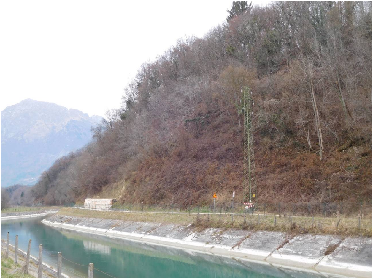
Foto 14: Vista delle fasce di intervento A e B.
