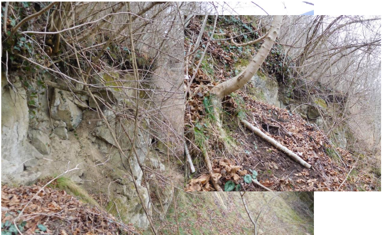
Foto 6, 7, 8: Particolari di aree alterate soggette a detensionamento. Qui si prevede l'esbosco, il disaggio e la successiva posa in opera di rafforzamento corticale con maglia 3x3.
