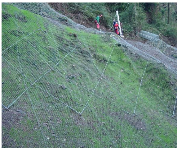
Figura 7: esempio di rafforzamento corticale differenziato per fasce maggiormente suscettibili al degrado (stesura di funi di rafforzamento limitata al coronamento)
