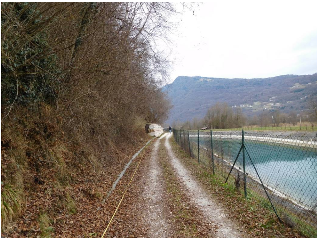
Figura 11: Vista di un tratto della pista ciclabile ora interdetta, in cui sono visibili la recinzione e il sedime stradale, da ripristinare a tratti per la sicurezza dell'utenza.
