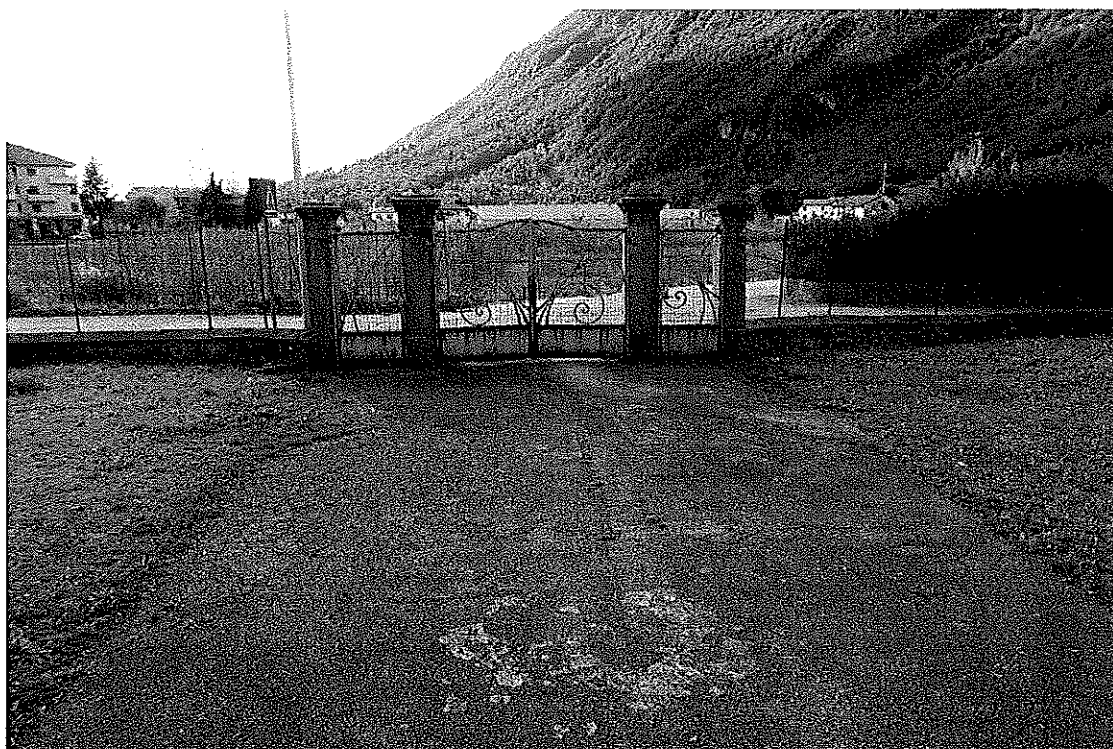
Foto 6 – particolare accesso ovest su Via Mangiarotti
