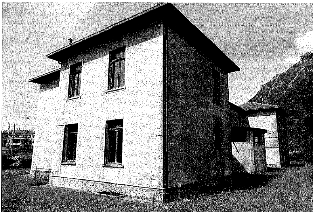
Foto 3 – vista da nord -est
