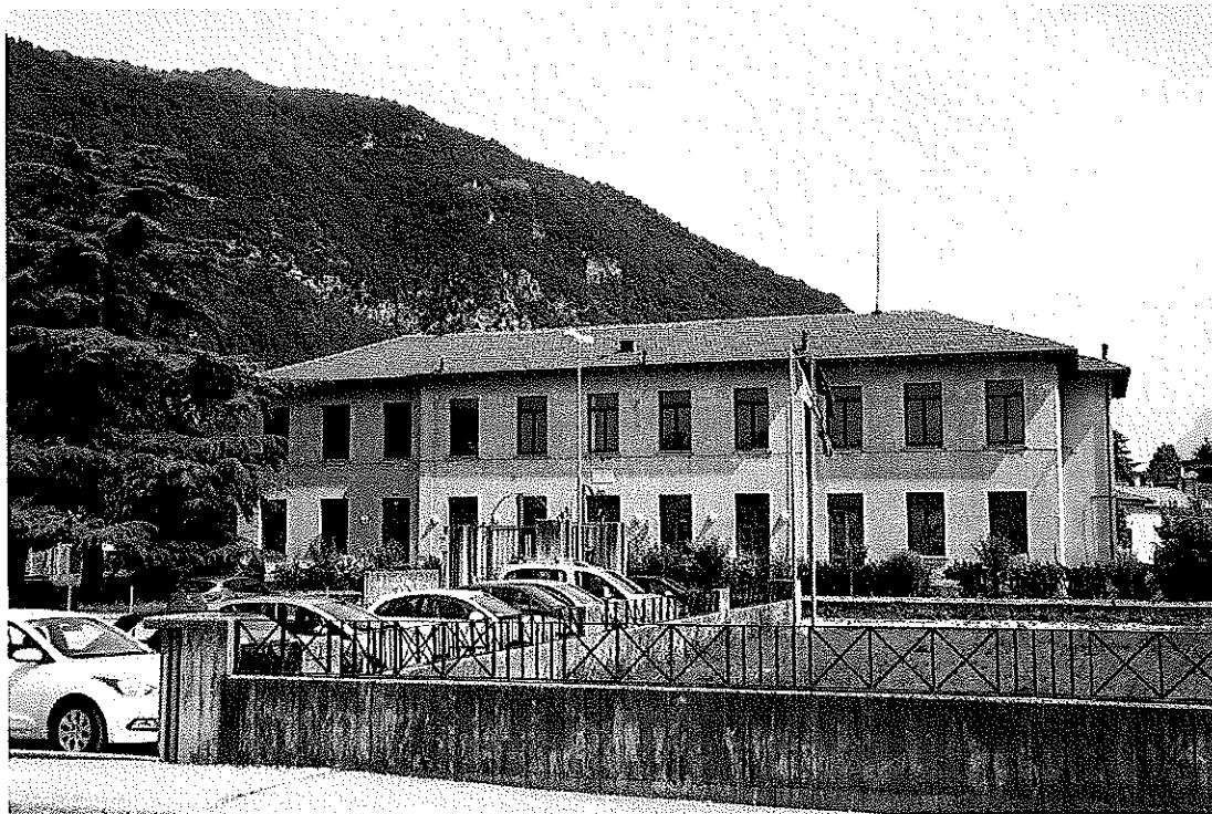
Foto 1 – vista da sud
