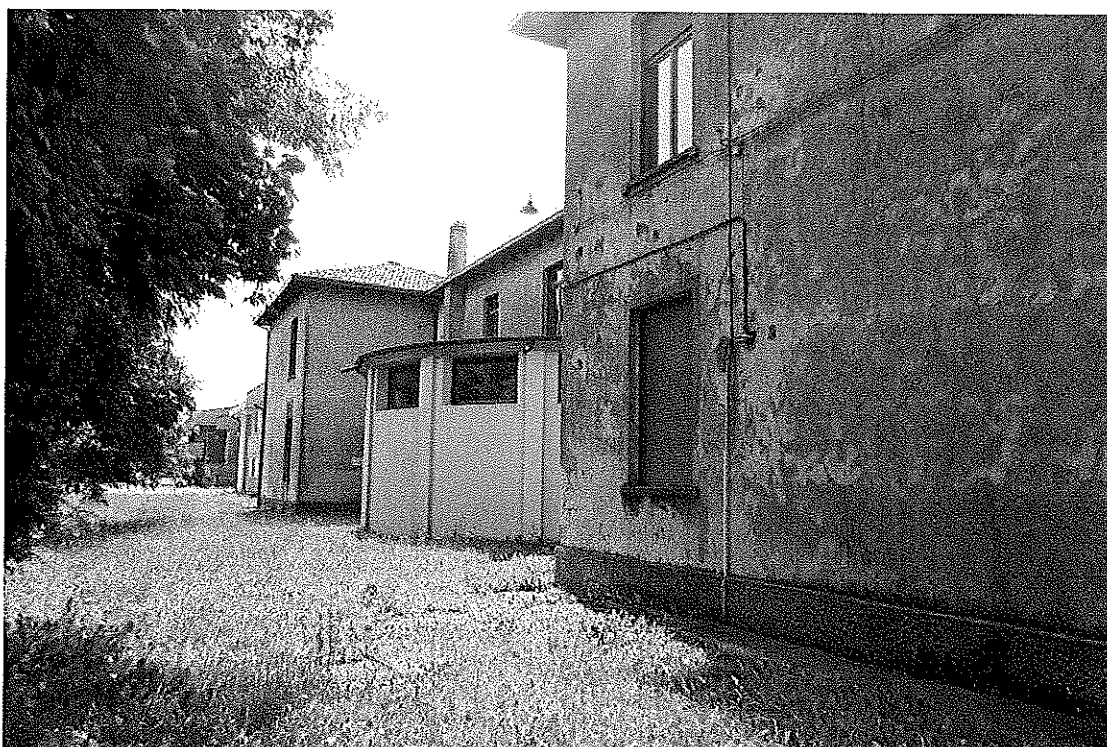
Foto 4 – vista fronte nord
