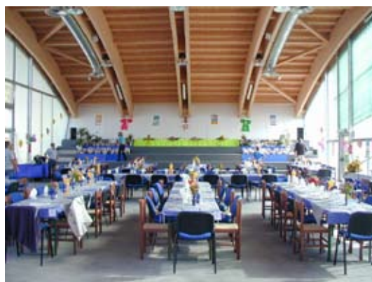
Interno del centro polifunzionale, si noti la struttura della copertura in legno lamellare
