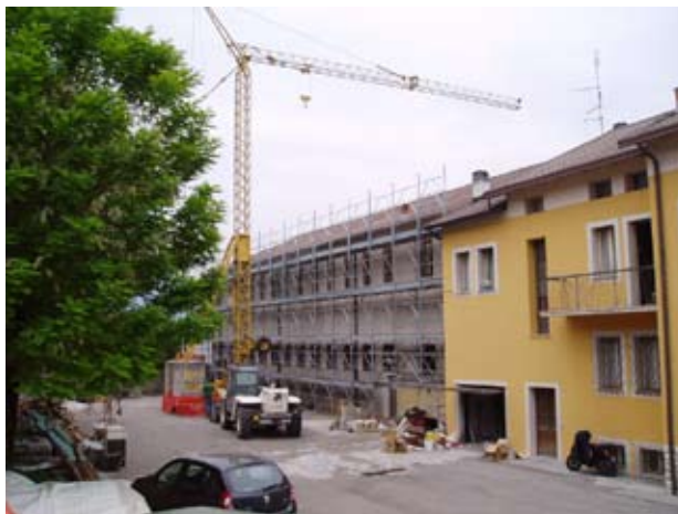
I lavori di ristrutturazione nella sala ex cinema di Rasai di Seren del Grappa
