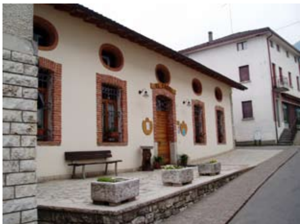
Facciata del casel.
