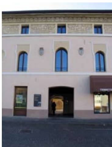
Trichiana, il Palazzo delle mostre (facciata)
