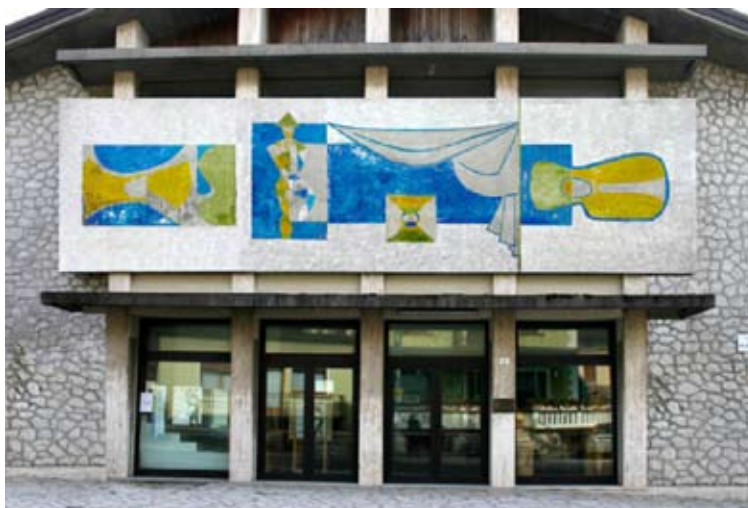
Vista esterno: entrata del teatro
