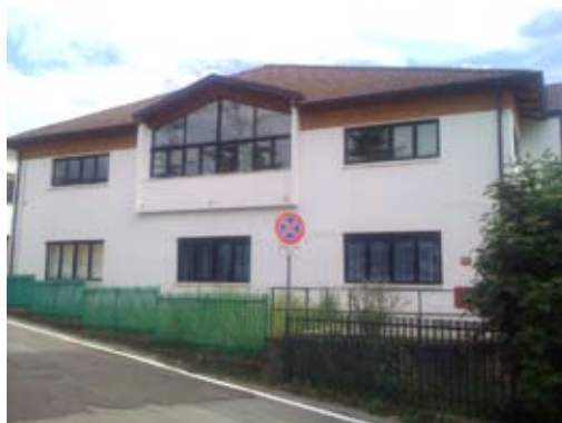
Facciata principale della biblioteca
