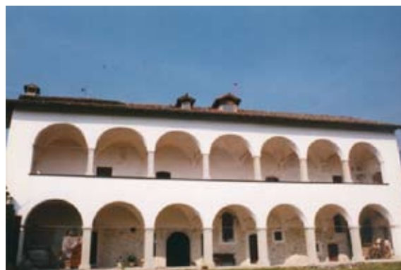
Castel Lusa, particolare della facciata.
