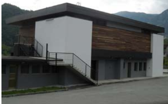
La sala polivalente di Arsié, ricavata sopra l'ala ovest degli spogliatoi del Campo sportivo comunale
