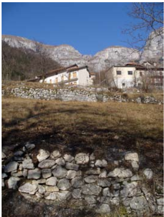
Particolari dei terrazzamenti: stato di conservazione e tessitura muraria
