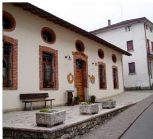
Ex latteria turnaria di Seren del Grappa: esempio di recupero per attività culturali.
