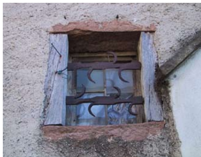
Dettagli di sistemi costruttivi di edilizia rurale in Alpago (foto Aldo Collazuol)
