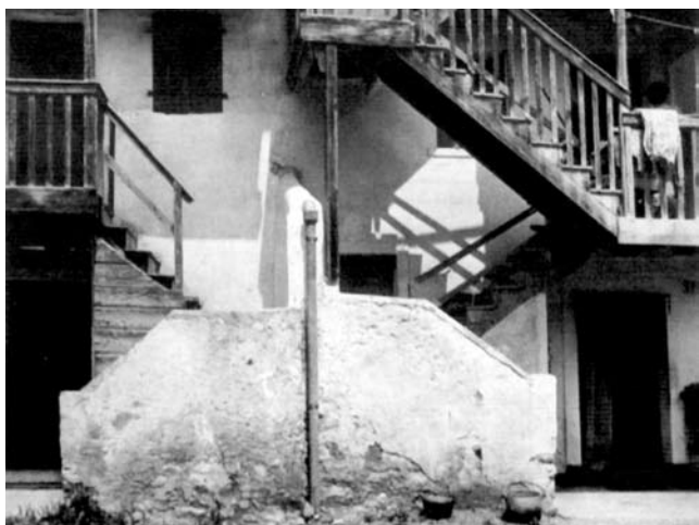
Seconda foto in alto a sinistra: ballatoio con piloni limitati al livello del piano terra
