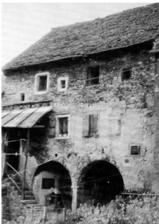
Casa con portico a Borsoi (Fonte: "L'edilizia tradizionale dell'Alpago" G. De Col)
