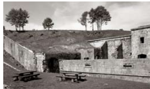
Dall'alto: vista del Forte Leone nel 1917; Vista del forte nel 2011; Il laboratorio munizioni.
