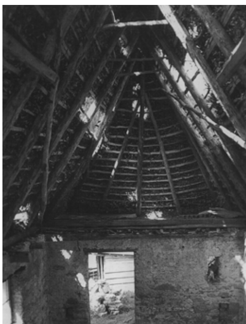
Struttura interna di una copertura in Vallonera (visibili le travi di controvento)
