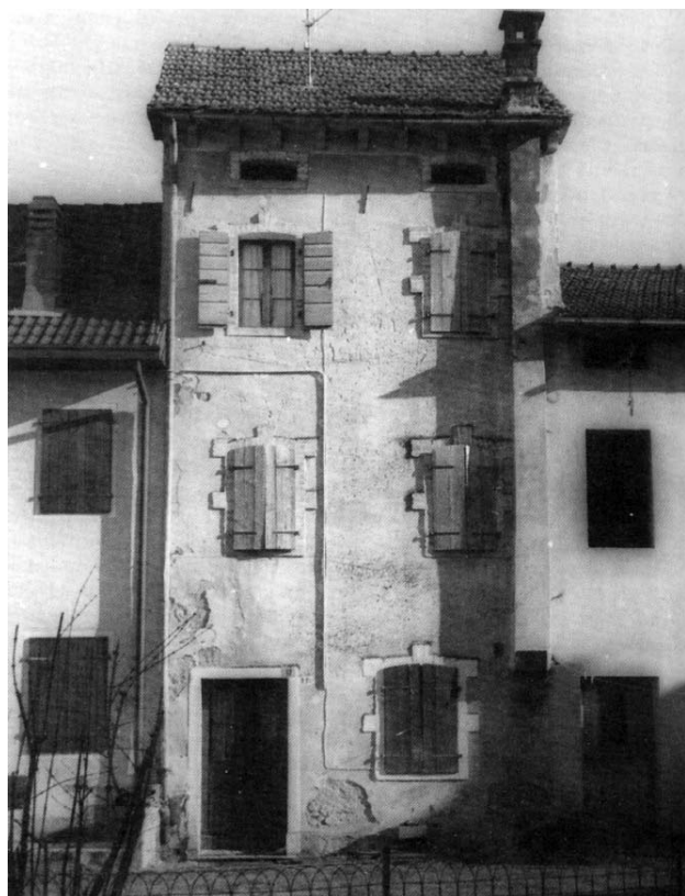
Edificio a parete piena di tipo singolo a Garna d'Alpago (Fonte: "L'edilizia rurale in Alpago" – A. Collazuol – D. Davià – A. Pucci)
