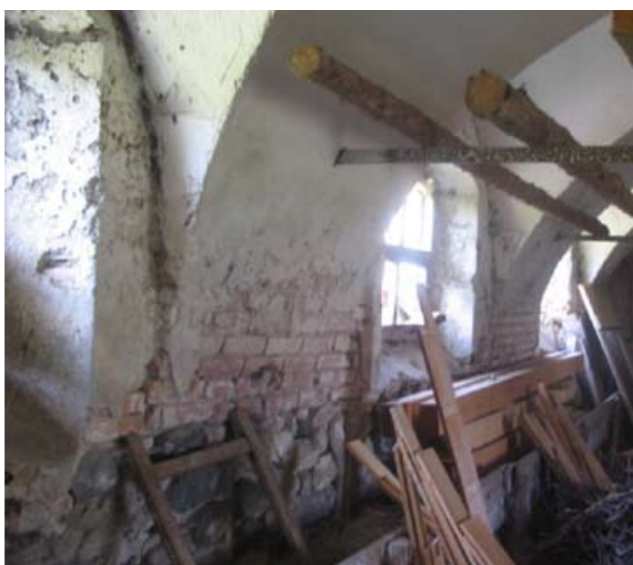
Particolare dell'interno di una stalla con volta a botte.
