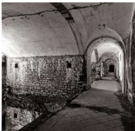
In alto: settore con struttura a cupola per osservazione eventuale incursione aerea Seconda e terza dall'alto: vista delle gallerie e corridoi del forte
