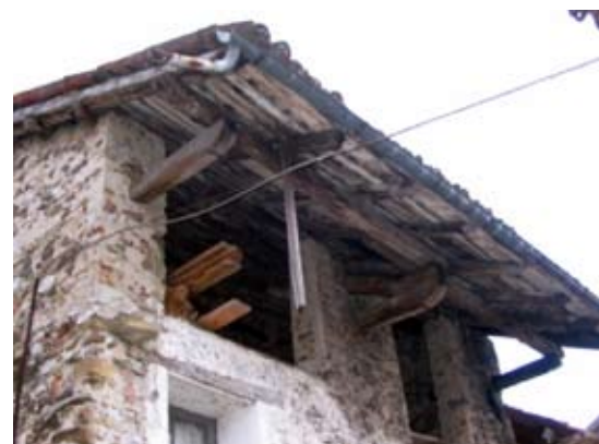
Puntoni e catene a sostegno dell'aggetto di copertura. Particolare di trave ligneo inserito nella muratura con funzione di mensola a sostegno dell'aggetto di copertura
