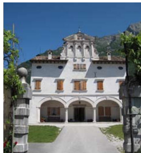
Dall'alto: localizzazione della villa su CTR La facciata principale della villa con il loggiato al piano terreno e il timpano.
