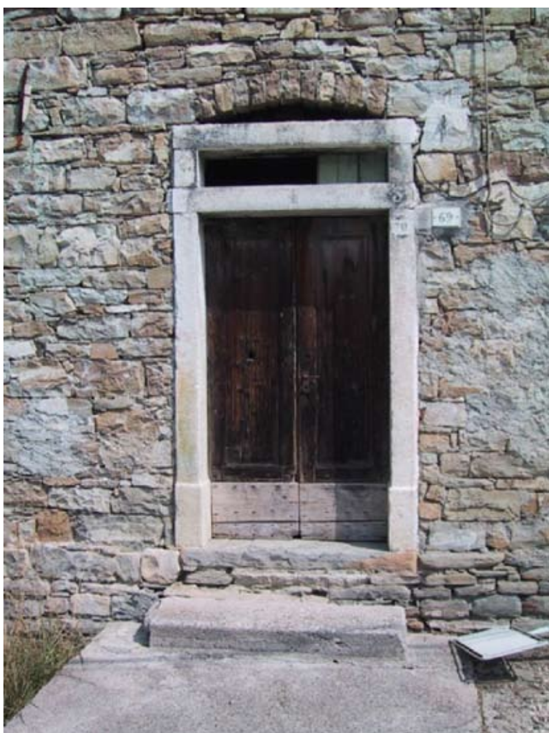
Dettaglio delle finiture in pietra di una porta di ingresso in Alpago (foto Aldo Collazuol).
