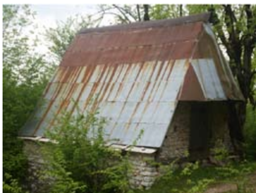
Lato Nord di un casòn. In primo piano la struttura del mazòl sopra all'ingresso del fienile
