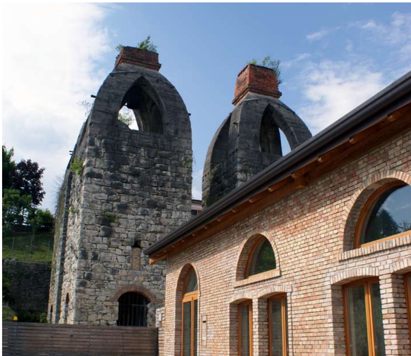
Particolare dei tre forni
