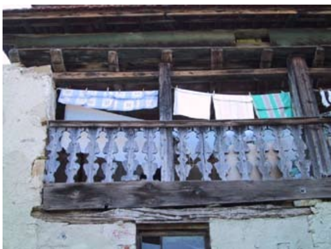
Casa con loggia a parapetto in legno a Puos: particolare (Foto Aldo Collazuol)
